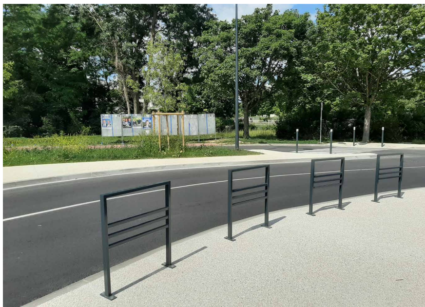
Barrières 3300 Mennecy - 91 - France
